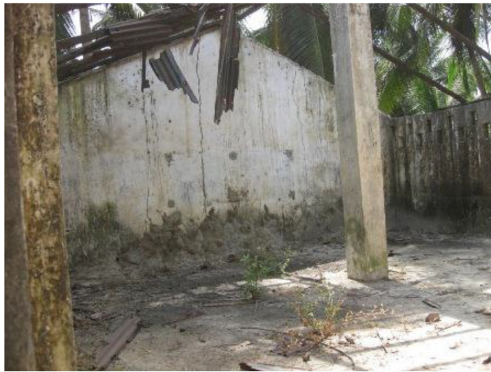
Estado em que o Centro se encontrava no início das obras
