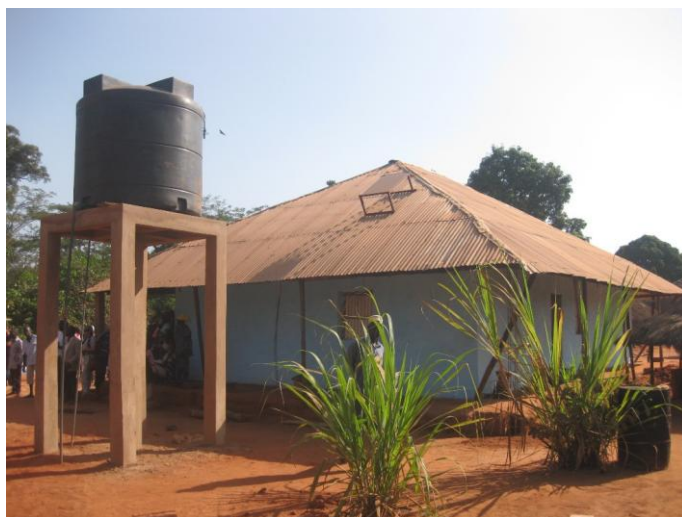
Depósito de água com o painel solar em cima do telhado da casa
